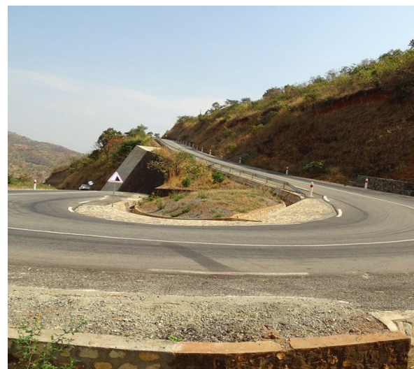
Route régionale réhabilitée reliant Tanzanie et Burundi, à MAKAMBA
