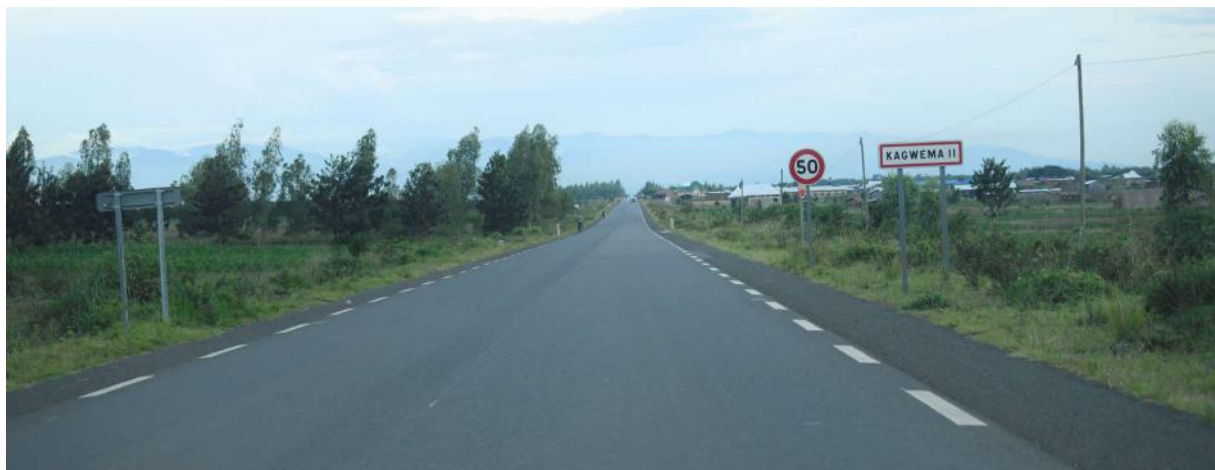
Route Bujumbura-Cibitoke (RN 5), nouvellement réhabilitée
