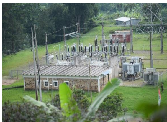
Barrage Hydro-électrique de Rwegura, à KAYANZA
